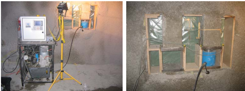
Bild 5: Mobile Druckprüfanlage, Insitu-Pressen und Probekörper mit Belastungs- und Messeinrichtung in der Tunnellaibung
