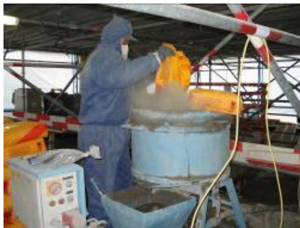
Bild 10: Beschickung des Mixers. (Bild: Jahn)
