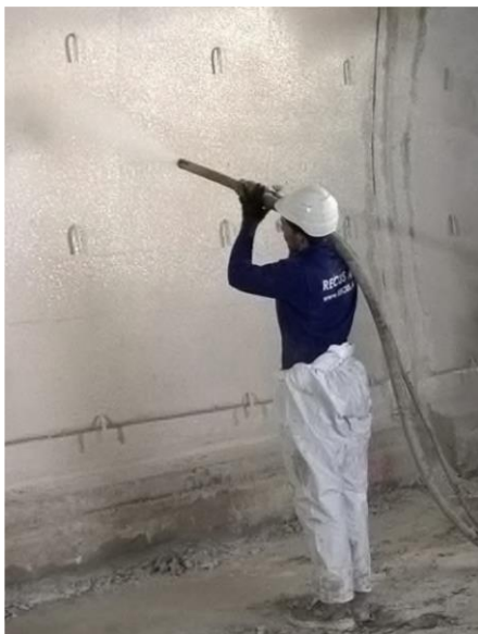
Bild 11: Applikation Spritzabdichtung
