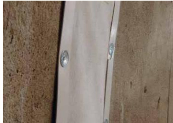
Bild 10: Drainageschlitz mit Abdichtungstreifen
