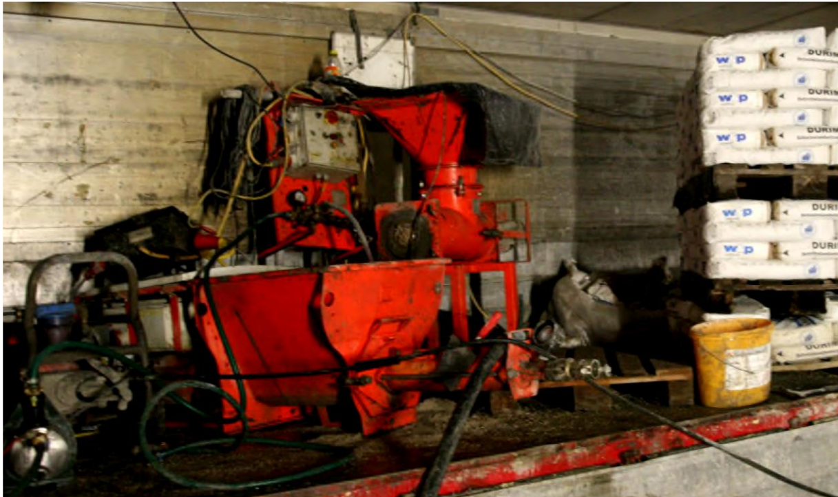
Bild 13: Schneckenpumpe zur Verarbeitung des Spritzbetons in der Firste
