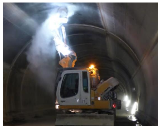
Bild 8: Fräsen der Drainageschlitz
