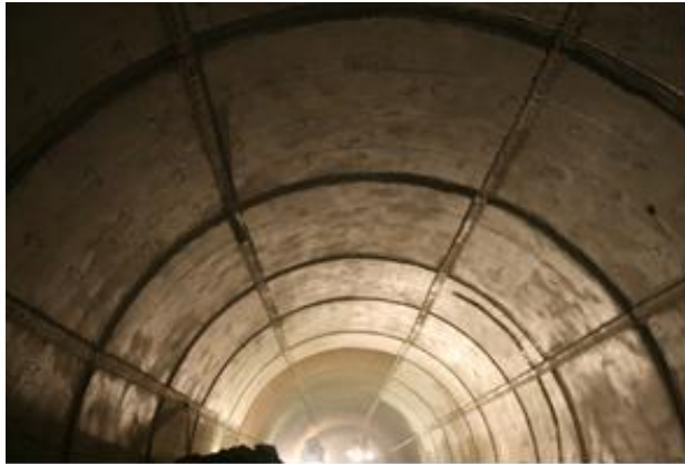
Bild 9: Drainageschlitz längs und quer
