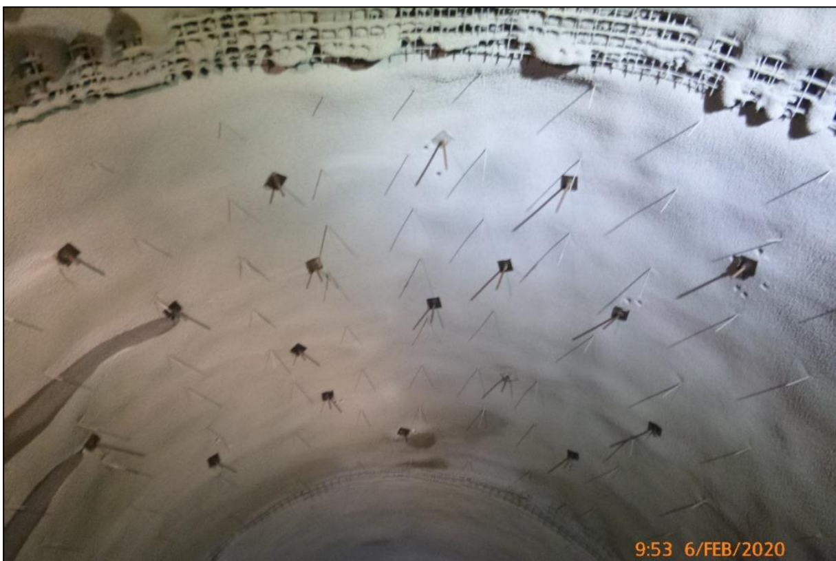
Bild 6: Stahlfaserspritzbeton mit Kavernenverankerungen (Bild: Philip Geisen)
