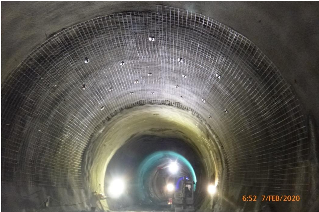
Bild 7: Mattenbewehrung der Kavernen (Bild: Philip Geisen)
