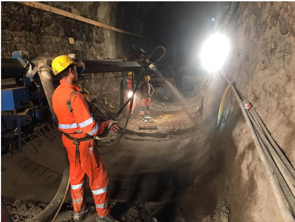
Bild 11: Spritzbetonarbeiten im Bosrucktunnel 2016.
