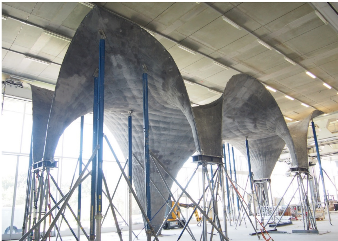
Bild 1: Gesamtansicht des Herstellungs-demonstrators: auf eine Seilnetzschalung gespritzter Carbonbeton für das Projekt NEST HiLo der ETH Zürich (Foto: Jan Bielak)
