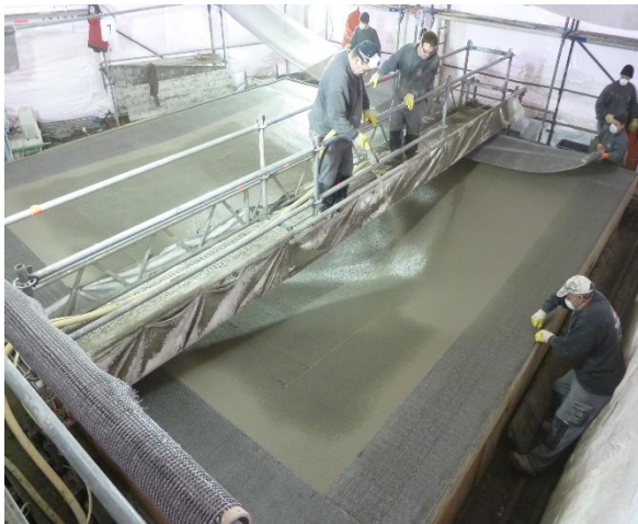
Bild 3: Herstellung in Spritzbetonbauweise mit lagenweiser Laminiertechnik (Foto: Alexander Scholzen [16])
