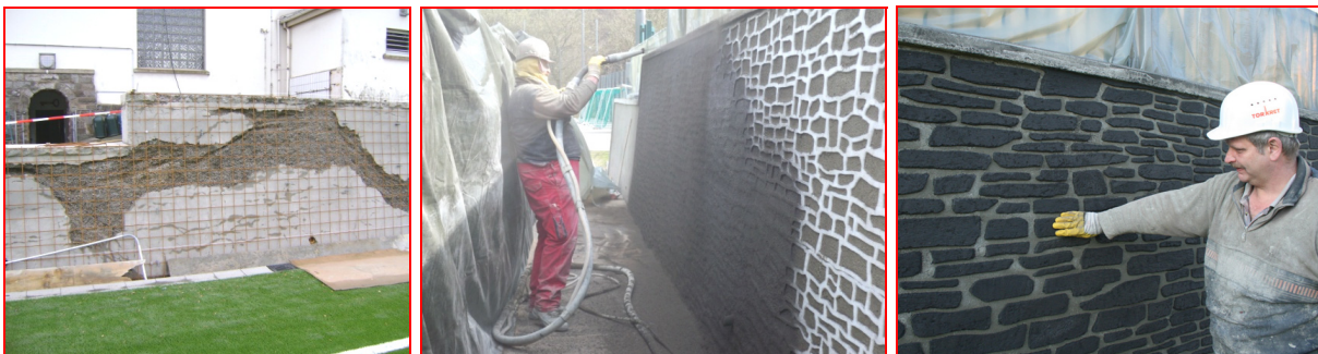
Bild 6: Stützmauer Sportanlage Hemer
