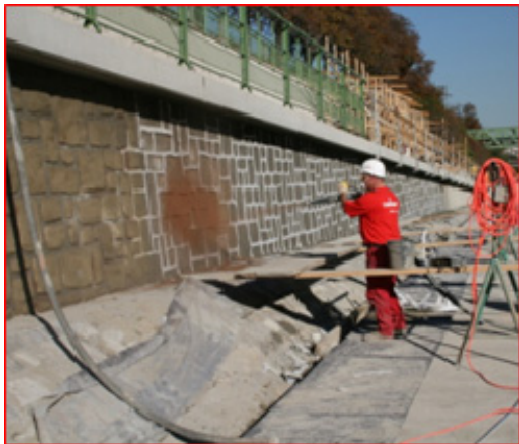
Bild 7: Reliefbetonauftrag auf neu erstellter rückverankerten Stützwand, Hardikgasse, Wien
