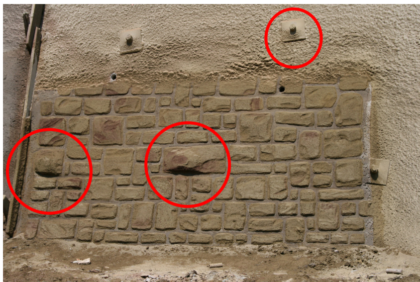
Bild 8: Integrierte Rückverankerung im Reliefbeton, Böschungssicherung Hardikgasse, Wien
