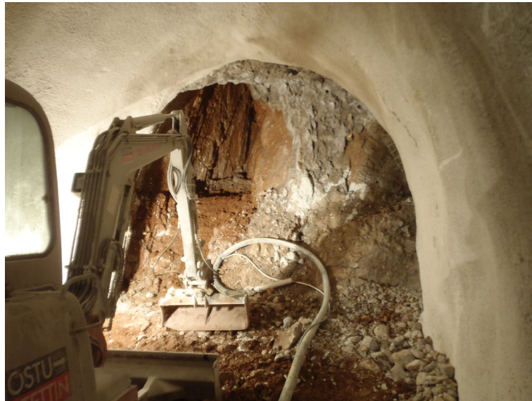
Bild 2: Ausbruch – Vortrieb im „Karst“
