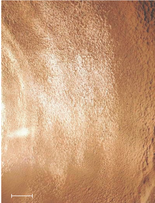
Bild 5: Druckwasserstollen in Hintermuhr: während der Bauzeit 2009; (Foto: Wacker Chemie AG).
