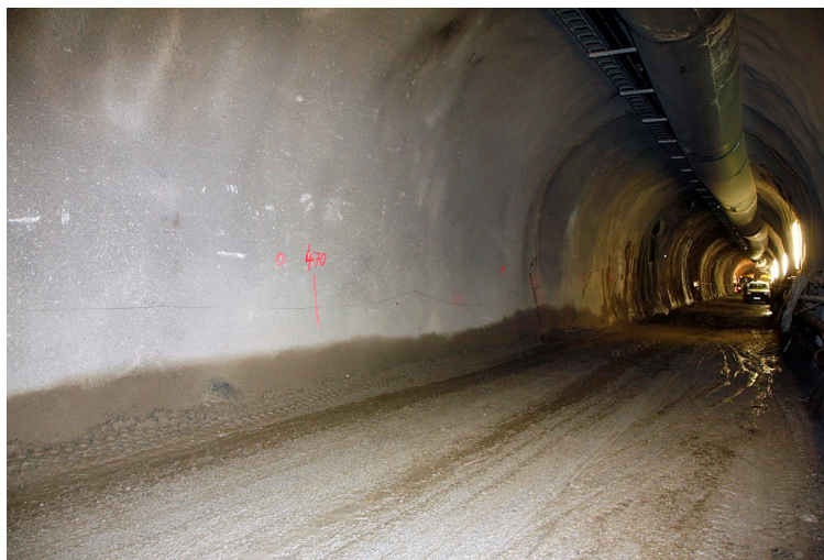
Bild 3: Stollenwand mit polymermodifiziertem Spritzbeton während der Bauphase im Jahr 2008, ohne Wasserflecken, (Foto: Wacker Chemie AG)
