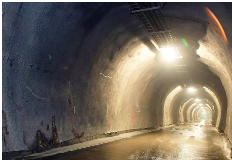
Bild 4: Stollenwand mit polymermodifiziertem Spritzbeton während der Nutzungsphase im Jahr 2011, (Foto: Wacker Chemie AG)
