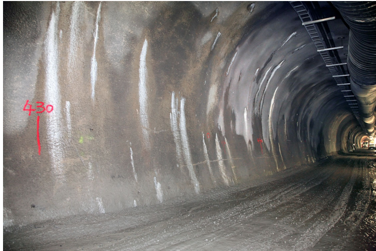
Bild 2: Stollenwand mit Standard Spritzbeton ohne Polymer während der Bauphase im Jahr 2008 vergleichbar zu 2011, mit Wasserflecken, (Foto: Wacker Chemie AG)
