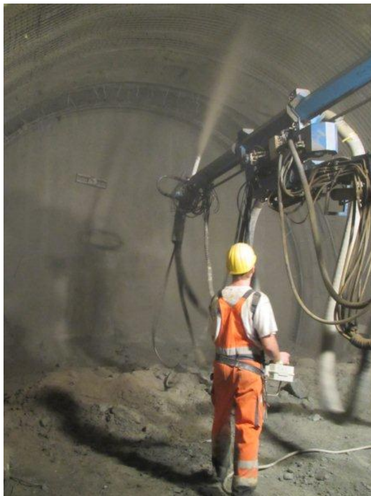
Bild 2: Spritzen von der Mischung 6a
