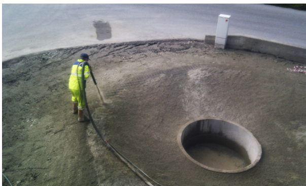
Bild 10: Herstellung des Spritzbetonuntergrundes (Bild: Wasser Tirol)
