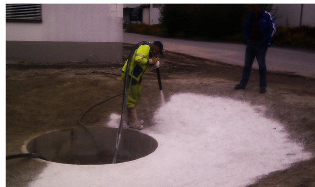
Bild 11: Spritzen der Folie (Bild: Wasser Tirol)
