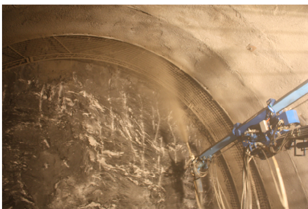
Bild 5: Produktveränderung – Spritzen (Bild: Wasser Tirol)
