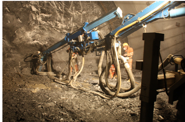
Bild 4: Produktveränderung - Spritzen (Bild: Wasser Tirol)
