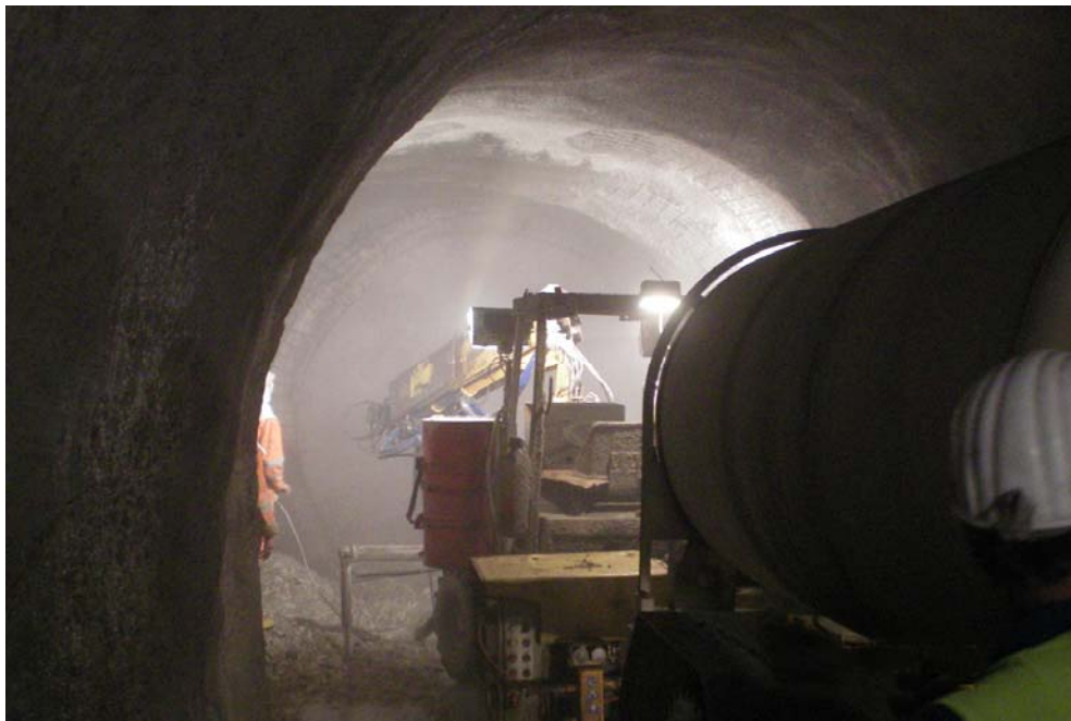
Bild 2: Auftrag des Spritzbetons mit kleinem Spritzroboter
