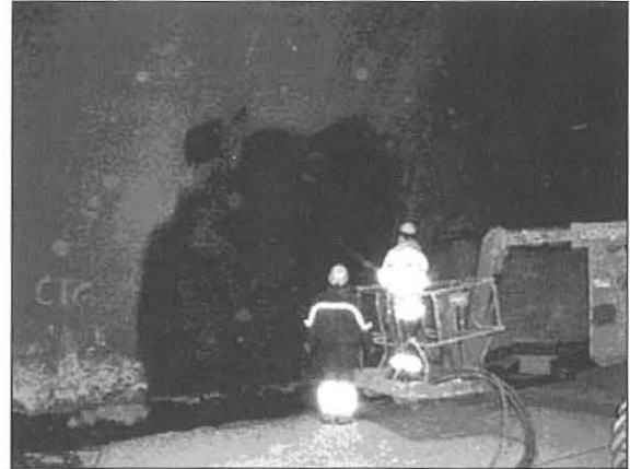
Bild 4: Spritzbetonauftrag im Tunnel
