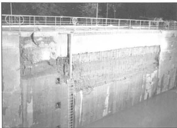
Bild 7: In einer Schicht instandgesetzte Lamelle
