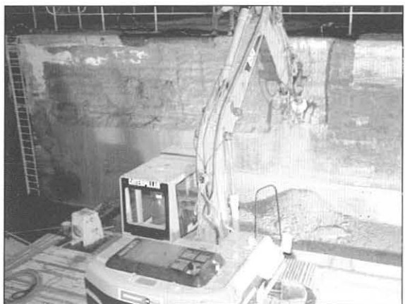
Bild 5: Bagger mit Walzenfräse beim Betonabtrag
