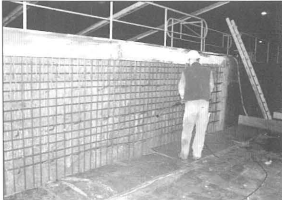
Bild 6: Einbau der statisch notwendigen Bewehrung
