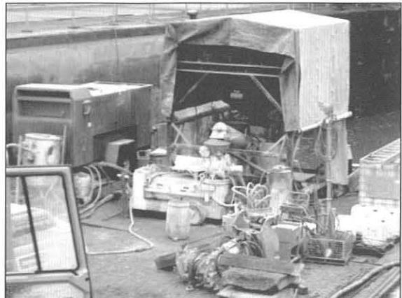
Bild 4: Spritzbetonanlage auf dem Ponton
