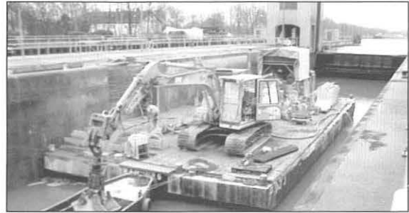
Bild 3: Ponton in der Schleusenammer
