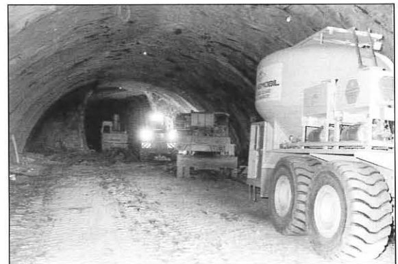
Bild 10: Tunnel Schulwald, Vortriebssituation
