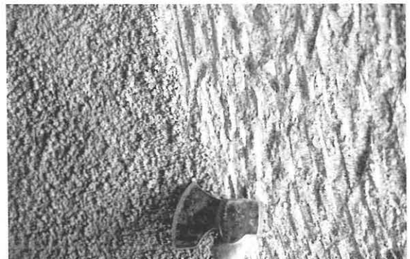
Bild 12: Spritzrauhe (links) und behauene Spritzbetonoberfläche
