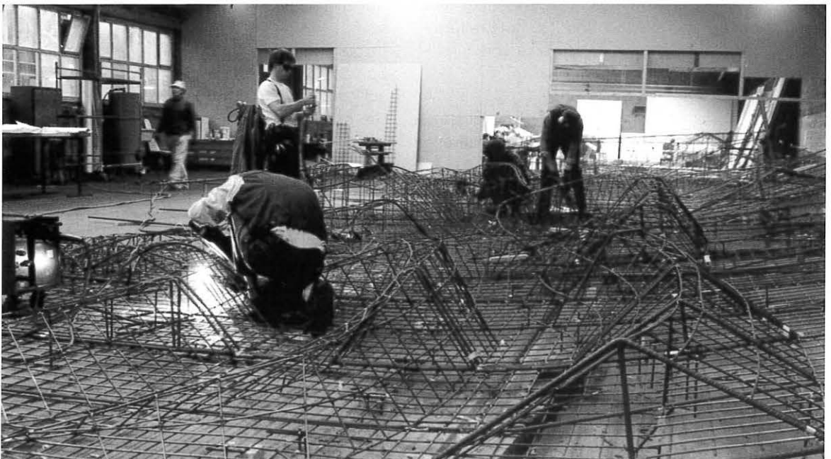
Bild 5: Vorfertigung des Rundeisenskelettes
