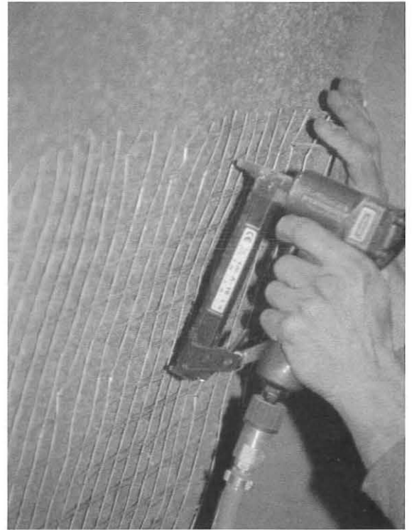
Bild 10: Befestigung des Glasfasernetzes
