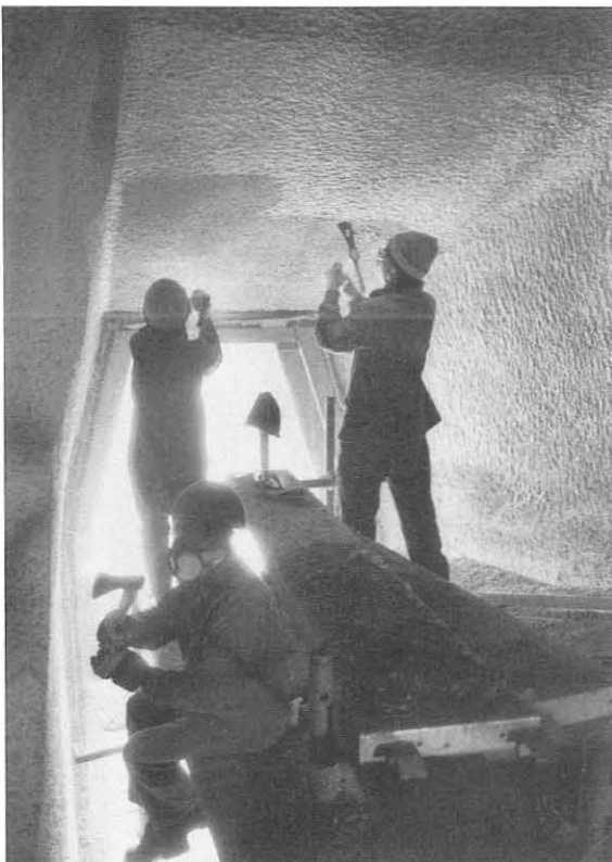
Bild 11: Behauen der Spritzbetonoberfläche
