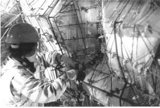
Bild 8: Befestigen der verlorenen Schalung aus Streckmetall
