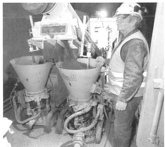
Bild 7: Beschicken von zwei Betonspritzmaschinen mit werkgemischtem Bereitstellungsgemisch für Stahlfasertrockenspritzbeton durch Zuteilschnecke mit Vorbenetzung
