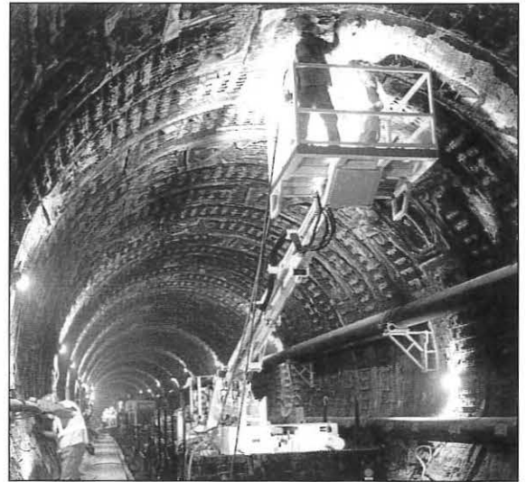
Bild 5: Entfernen des brandgeschädigten Betons der Stahlbetontübbinge während der Instandsetzungsarbeiten
