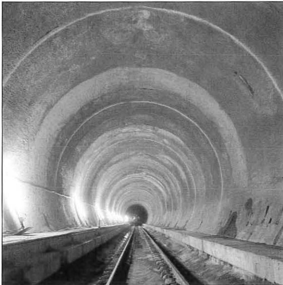
Bild 8: Mit stahldrahtfaserbewehrtem Spritzbeton instandgesetzter Tunnelabschnitt vor dem Wiedereinbau von Fahrleitung, Signalanlagen und weiteren Vorrichtungen
