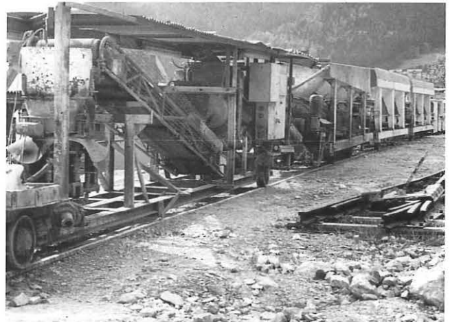
Bild 7: Der gesamte Spritzzug nach etlichen Stunden Betrieb im Stollen
