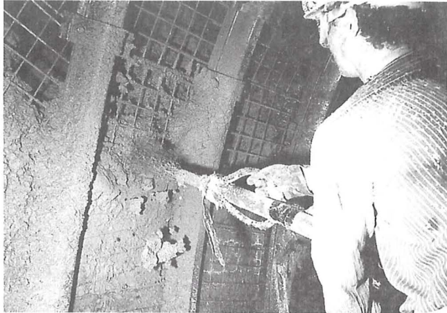
Bild 5: Eine mögliche Variante zur Ausbauhinterfüllung
