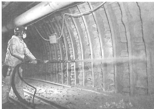
Bild 6: Streckensanierung im Bergwerk Sophia Jacoba
