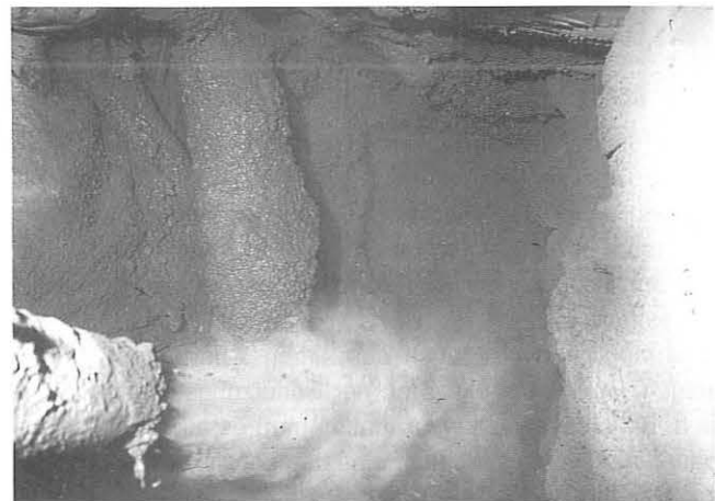
Bild 4: Herstellung eines Baustoffdammes
