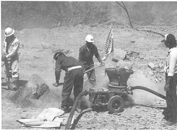
Bild 4: Füllen der "Springbok" Spritzmaschine mit händisch vorgemischtem Mischgut mit Rockshot-Bindemittel
