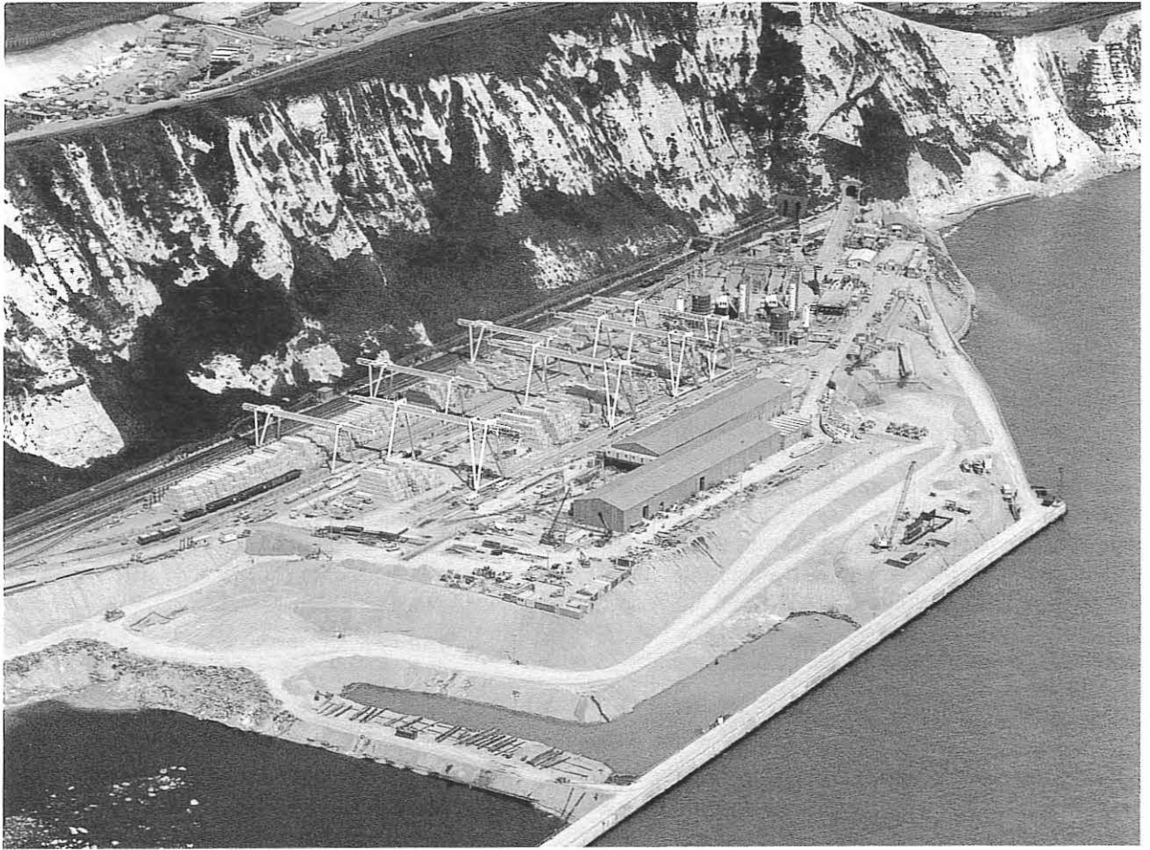
Bild 1: Baustelle Shakespeare Cliff
