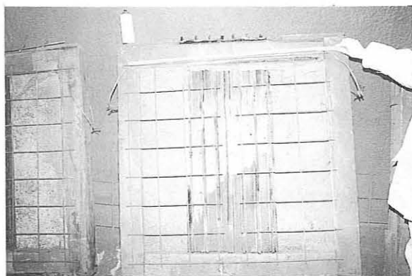
Bild 18: Fugenband in Versuchsplatte 7 vor dem Einspritzen
