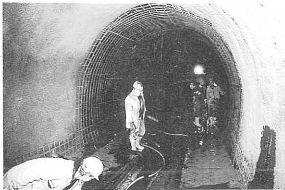
Bild 5: Spritzbetonauskleidung des Abwasserstollens
