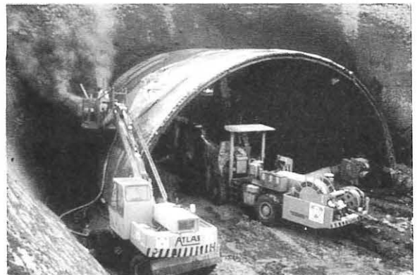
Bild 2: Spritzbeton als Sicherungsmittel im modernen Tunnelbau
