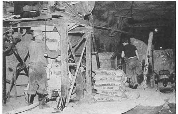
Bild 6: Stationäre Spritzbetonanlage
