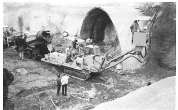
Abb. 8: Naßspritzgerät auf Raupenfahrwerk mit einem Spritzmanipulator
