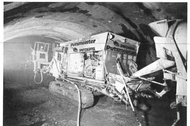
Abb. 9: Leistungsfähige Naßspritzanlage
